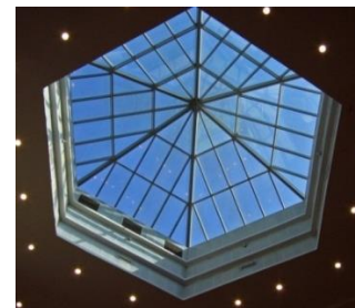
Рис. 2. Зенитный фонарь зимнего сада изнутри
