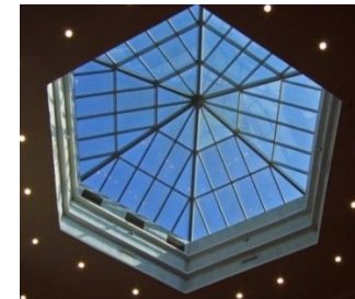
Рис. 2. Зенитный фонарь зимнего сада изнутри
