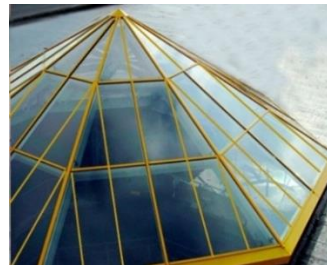
Рис. 1. Зенитный фонарь зимнего сада снаружи
